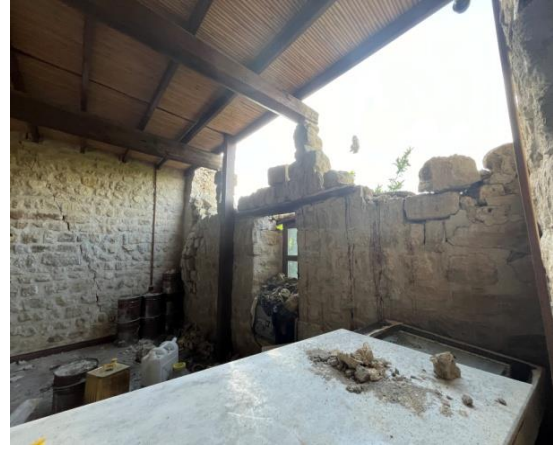
Görsel 9: 3 Nolu Oda Doğu Cephesi
