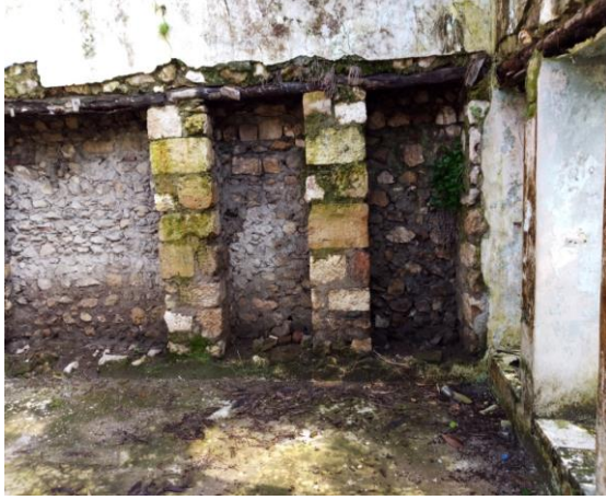
Görsel 17: İkinci odanın komşu duvarına bitişik cephesindeki nişler
