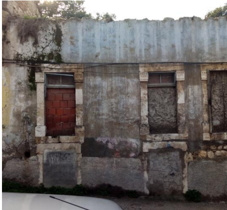
Görsel 15: İkinci odanın Saydam Caddesine bakan cephesi
