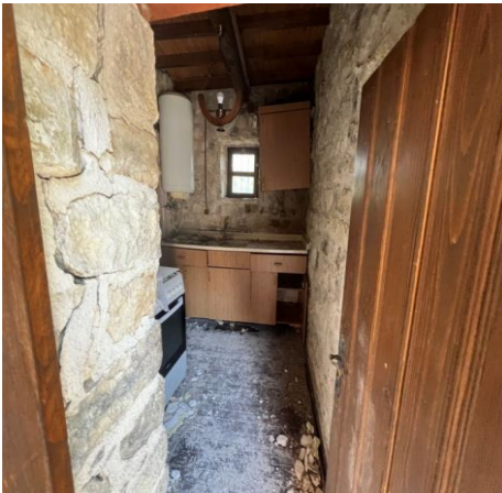
Görsel 10: 4 Nolu Oda Giriş Kapısı
