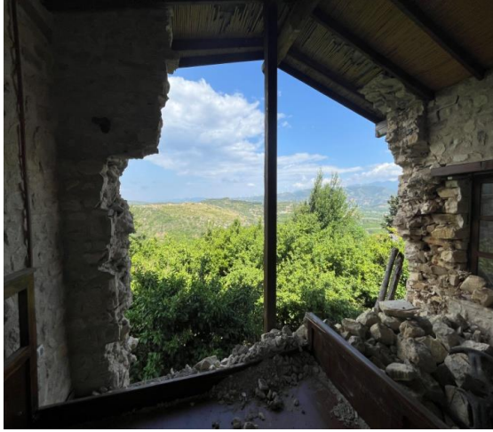
Görsel 17: 7 Nolu Oda Doğu Cephesi
