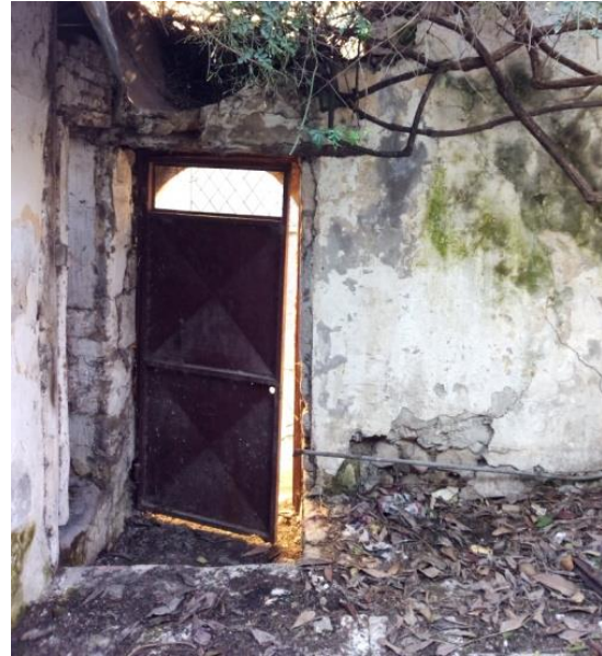
Görsel 3: Dış kapının avludan görünüşü
