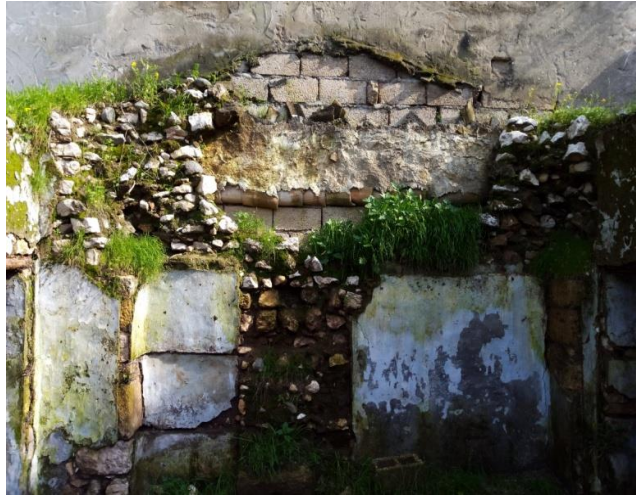
Görsel 23: Salonun komşu duvarına bitişik duvarında yer alan nişlerin izleri.
